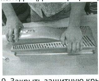
9. Закрыть защитную крышку надев её сверху на светильник, совместив крепления с защёлками и надавить до щелчка усилием 3-4 кг
