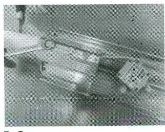
5. Закрепить светильник на монтируемую опору. Закрутить болты с усилием крутящего момента не более 29 Н/м
