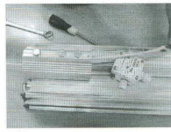
4. Установить на монтируемую опору предварительно продев сетевой провод
