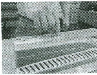
1. Открутить винт (барашек) на защитной крышке светильника
