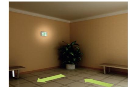
Дистанция между двумя соседними световыми указателями по пути эвакуации не должна превышать значение расстояния распознавания используемых знаков. При этом, согласно СП 256.1325800.2016, рекомендуется ограничивать расстояние между ближайшими световыми указателями до 25 м. [7, пп. 5.1.5; 9, пп. 5.4]
